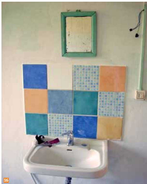
16 Piastrelle fugate a calce con intorno pittura di calce.
